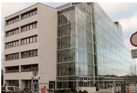
przeszklona klatka, zdj. nr 24, fot. MP
