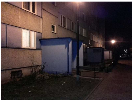
wejście do klatki, zdj. Nr 20, fot. MP
