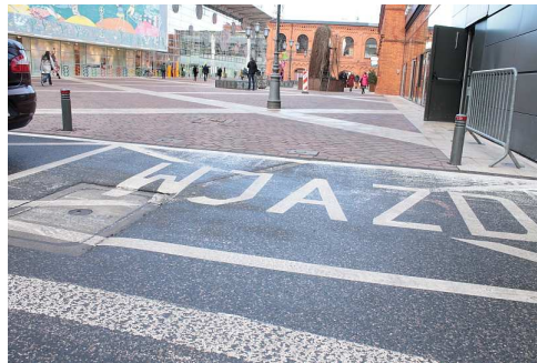
Bariery podnoszone i opuszczane elektrycznie, zdj. nr 39 i zdj. nr 40, fot. MP
