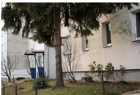
wejście do klatki, zdj. nr 23, fot. MP
