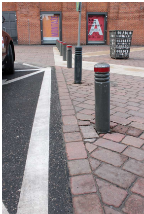
Bariery podnoszone i opuszczane elektrycznie, zdj. nr 39 i zdj. nr 40, fot. MP
