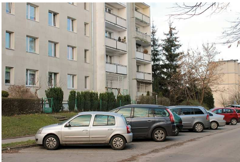
parking , zdj. nr 28, fot. MP
