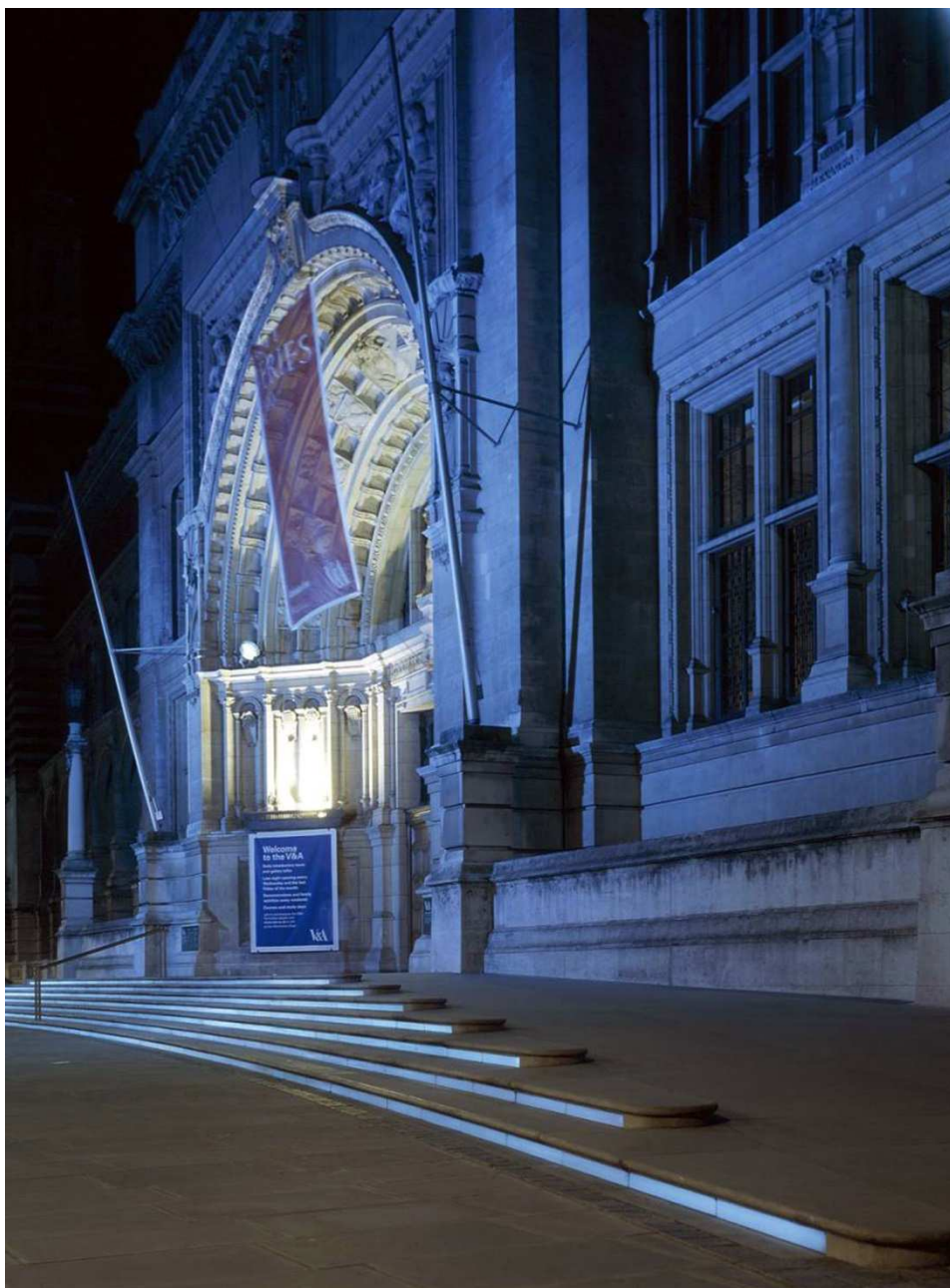
Il. 6. Victoria And Albert Museum, Londyn, arch. Pringle Richards Sharratt. Źródło: http://www.prsarchitects.com/projects/arts-civic/victoria-and-albert-museum-main-entrance (dostęp: 13.11.2017).
